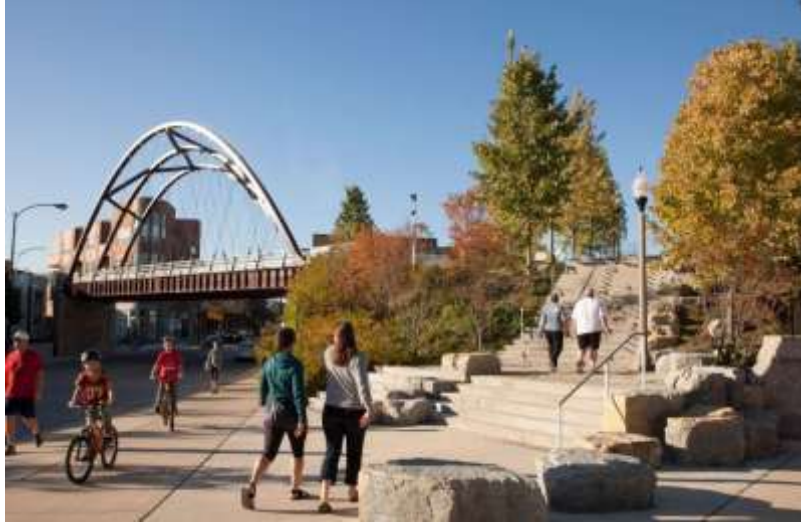
الشكل رقم (10) توضح "جسر فولاذي مصمم بهيكل فولاذي مرن مقاوم للصدا والاهتزاز".
