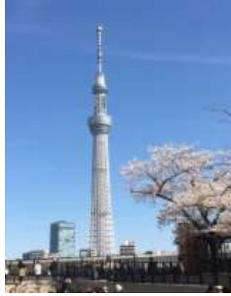
الشكل (5) - يوضح برج طوكيو سكاى تري، نظام Shinbashira-seishin المقاوم للزلازل مستوحى من المعابد اليابانية القديمة، يتحمل زلازل بقوة 9 درجات ويحتوي على نظام تخميد يقلل الاهتزاز بنسبة 50%. المصدر: Tokyo Skytree, design by Nikken Sekkei, Highlighting Japan, 2012
