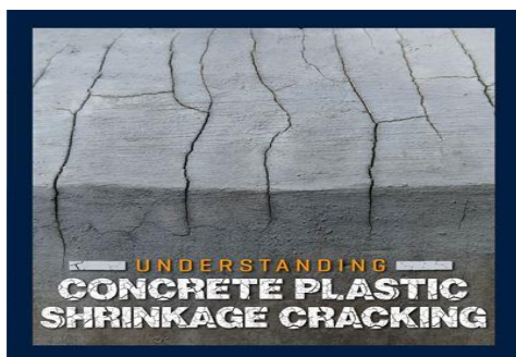
شكل (2-1) شروخ الانكماش البلاستيكي
