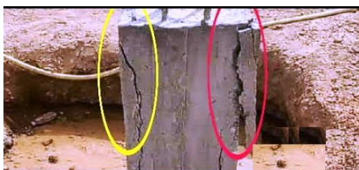
شكل (2-6) يوضح شروخ سوء التنفيذ
