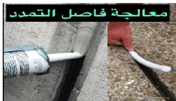
شكل (3-3) يوضح طريقة تنفيذ فواصل التمدد في البلاطات الخرسانية
