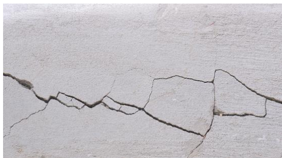
شكل (2-2) يوضح الشروخ الحرارية
